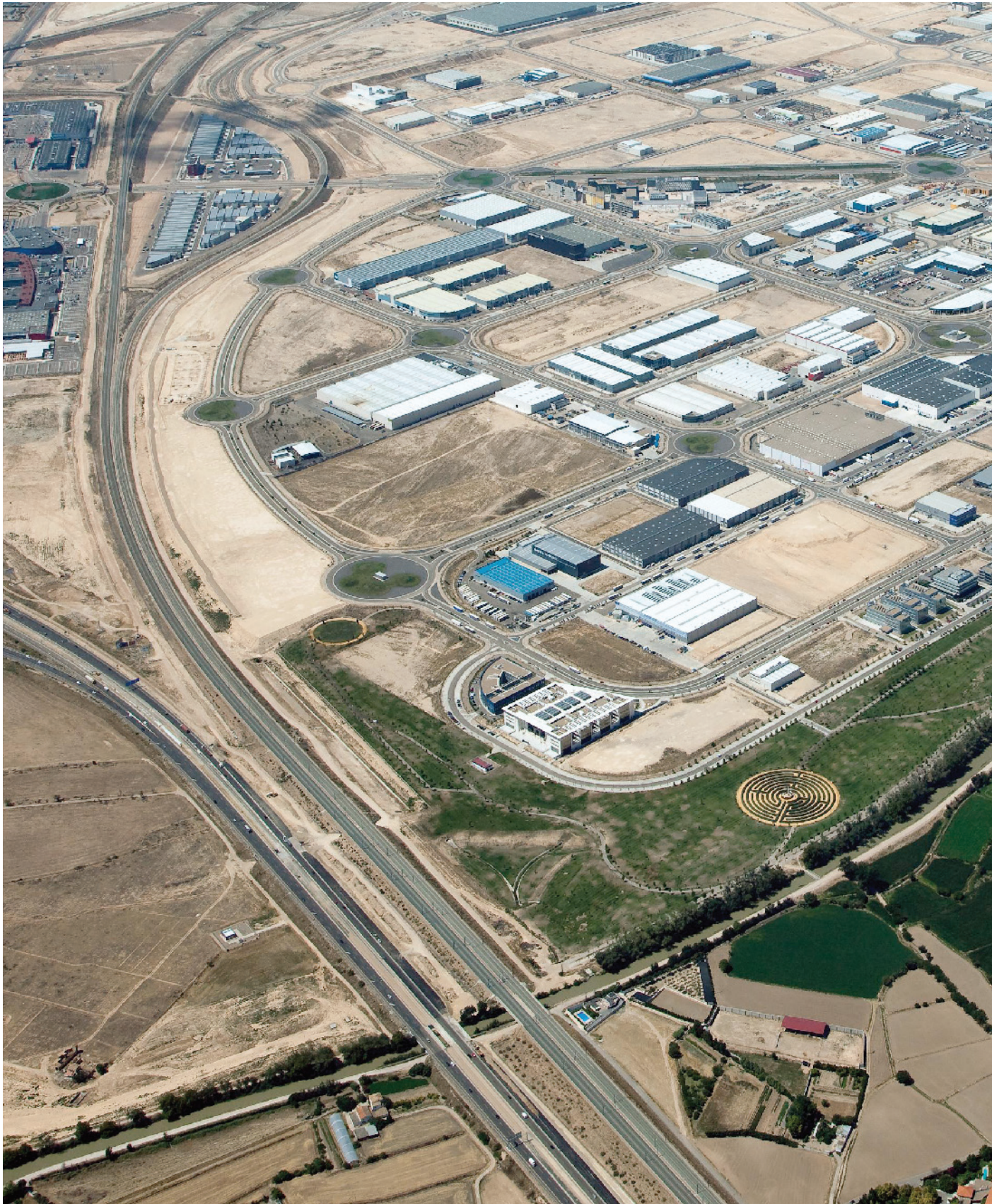
Plataforma Logística de Zaragoza, PLAZA.
